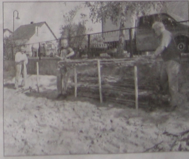
Sicherung: Diese Mitarbeiter des Wasser- und Bodenverbandes bauen zur Sicherung des späteren Teichrandes Faschinen ein.
